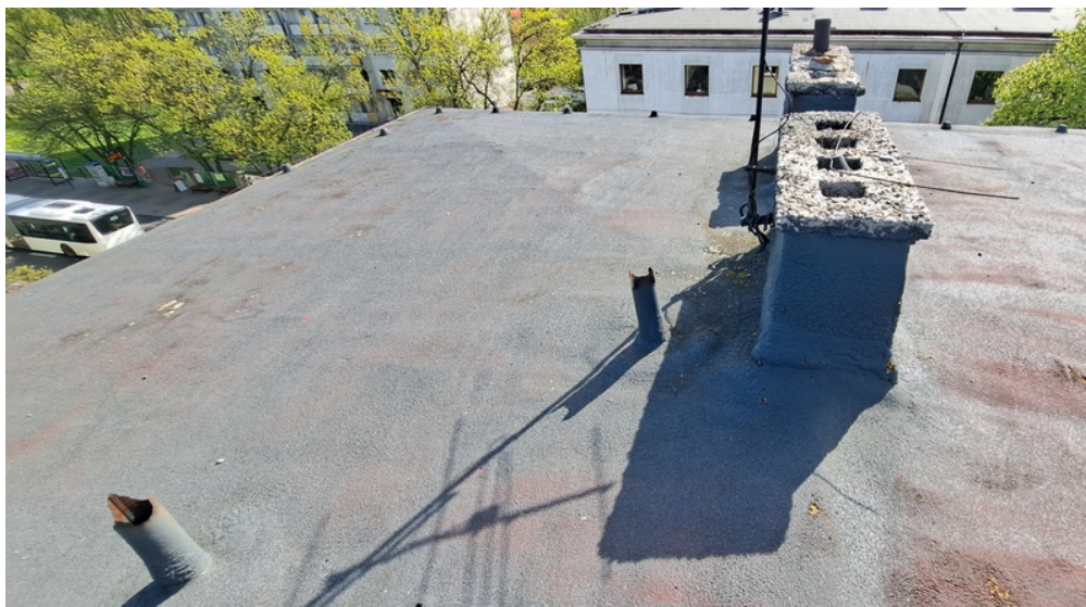
Fot. 9. Widok pokrycia połaci dachowej oraz kominów do przemurowania.
