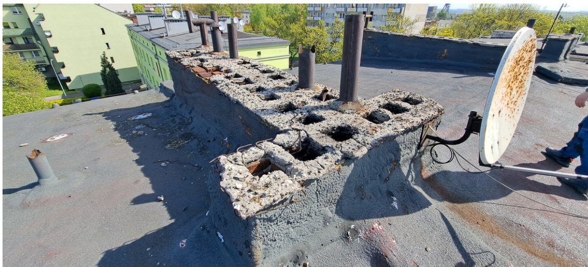
Fot. 6. Widok pokrycia połaci dachowej oraz kominów do przemurowania.
