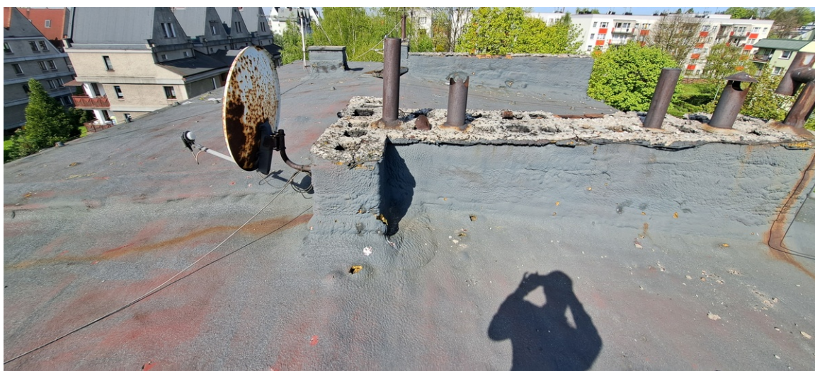
Fot. 7. Widok pokrycia połaci dachowej oraz kominów do przemurowania.
