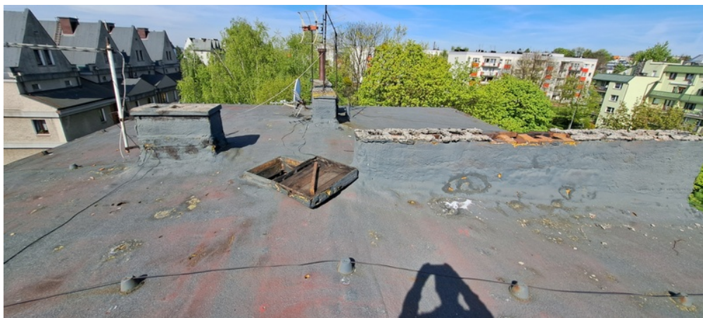
Fot. 10. Widok pokrycia połaci dachowej i wyłazu do wymiany.
