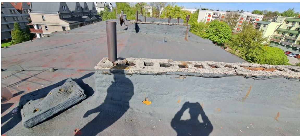
Fot. 8. Widok pokrycia połaci dachowej oraz kominów do przemurowania.
