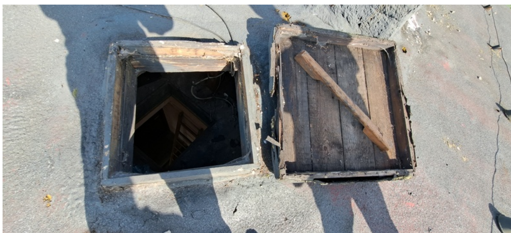
Fot. 11. Widok pokrycia połaci dachowej i wyłazu do wymiany.
